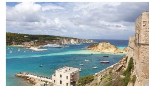
Fenomeno Erosivo del 5 Agosto 2020 - "Isola Cretaccio" - Isole Tremiti - Puglia - Suolo - foto di Giovanni Ciccotti
